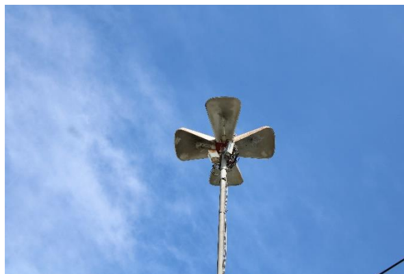
Figura 5 - Projeção dos braços – Suporte de topo com 4 pétalas
